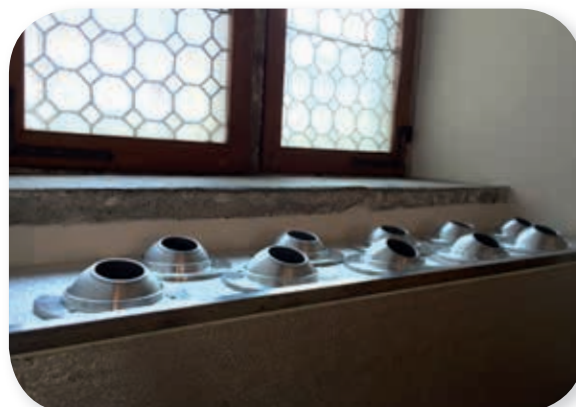
Vista del sistema con paneles de cobertura
