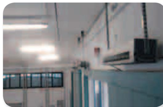
flusso di acqua atomizzata sostenuto dal ventilatore delle testate
