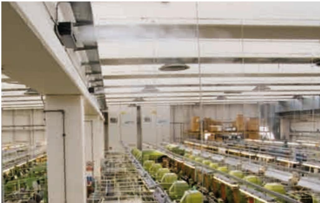
**Fig. 3 - Testate ventilanti in funzione**
