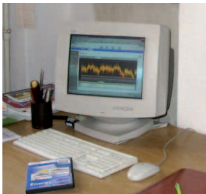
Energy2120 installato presso il prosciuttificio A. Fontana. Monitoraggio continuo, storicizzazione ed elaborazione dei dati raccolti attraverso il modulo software per supervisore PVENGMBLDO
