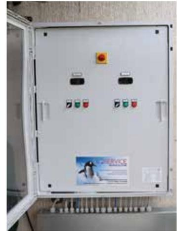
Fig. 1.c - Controllore iJW montato su quadro esterno customizzato
