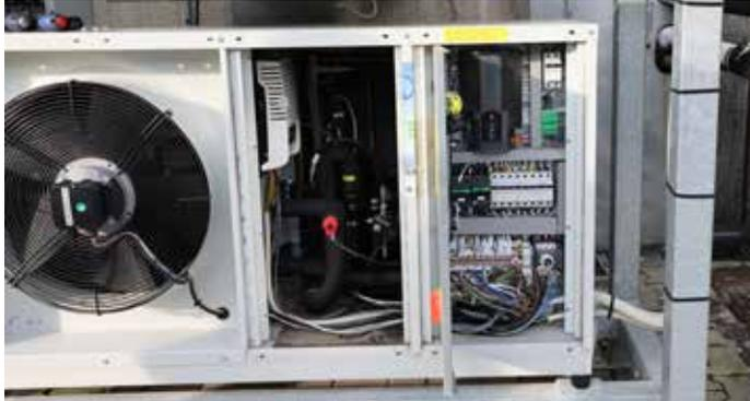
Fig. 1.b - Hecu e inverter PSD2 montati su rack esterno
