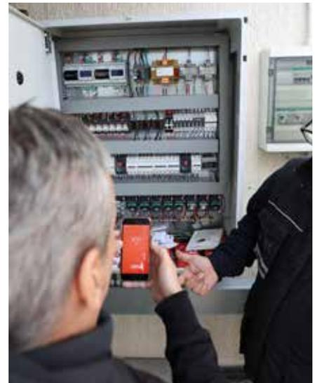
Fig. 1.d - Vista interna del quadro con driver EVD e modulo Ultracap
