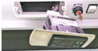
Ausbau des vorhandenen elektronischen Steuergeräts und Austausch des mechanischen Thermostatventils durch das EEV-Ventil.
