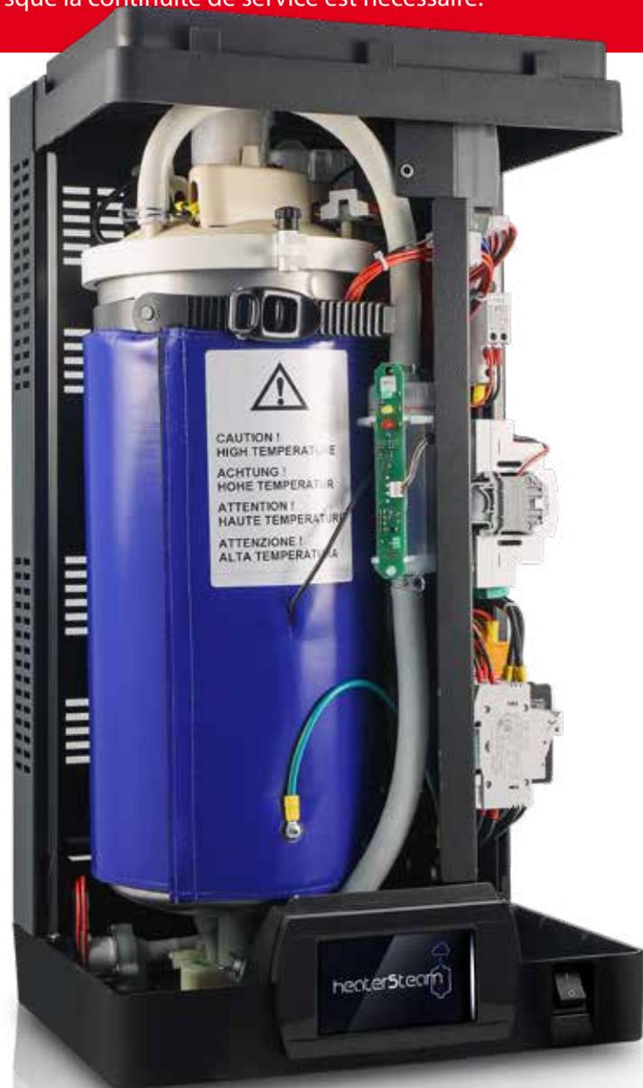
Par ses caractéristiques, l'humidification à la vapeur reste la solution préférentielle dans les applications où l'hygiène reste la priorité, comme dans les laboratoires de recherche ou l'industrie agroalimentaire: la vapeur est en effet complètement aseptique et ne transporte pas de particules solides, des qualités intrinsèques qu'elle conserve sans devoir traiter l'eau d'alimentation.
